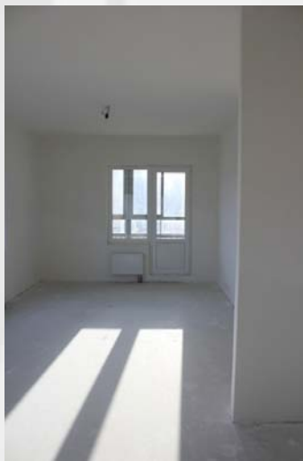
Фото 2. Общий вид и состояние оцениваемой квартиры
