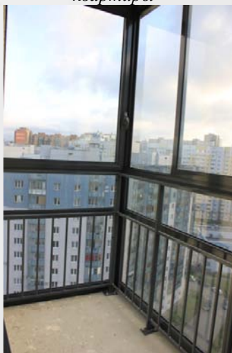
Фото 5. Общий вид и состояние оцениваемой квартиры
