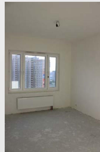
Фото 3. Общий вид и состояние оцениваемой квартиры
