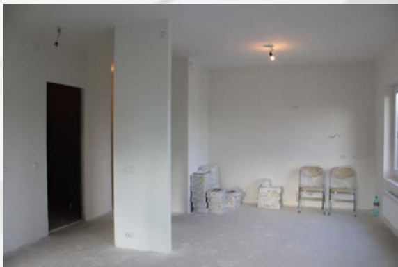
Фото 4. Общий вид и состояние оцениваемой квартиры
