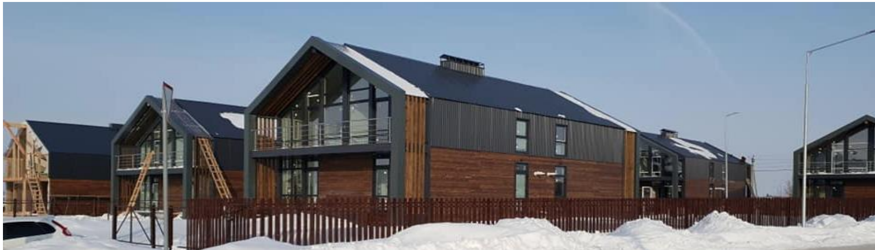
Строительство энергоэффективных домов «ДОН» в проекте «Экодолье Самара»
