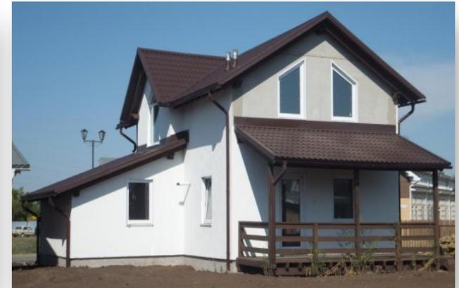
Компания «Экодолье» в консорциуме с компанией «Мосстрой 31» и ведущими производителями энергоэффективного инженерного оборудования (солнечные батареи, рекуператоры и т.д.), реализует проект по строительству ИЖД «КАМА» по технологии несъемной опалубки «НЕОПОР»
